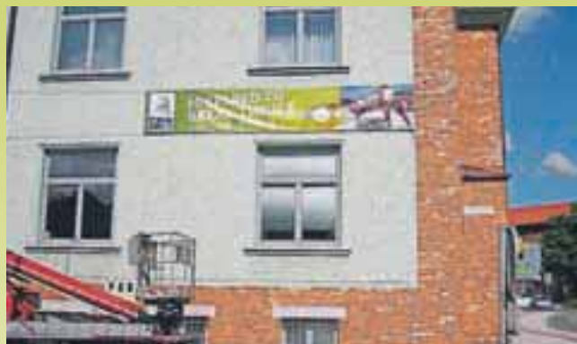
Transparent na občinski stavbi
